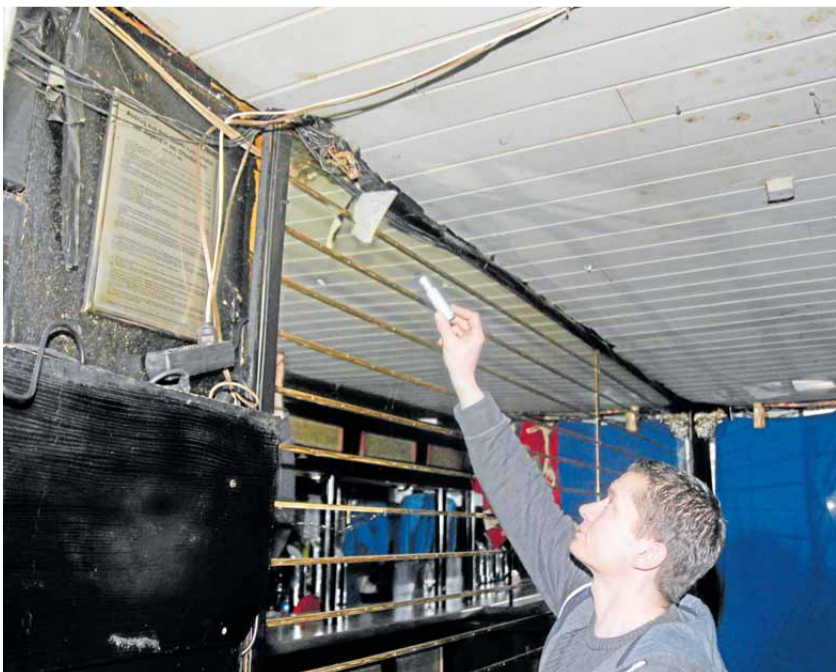
Pächter Ronny Danker zeigt auf die Stromkabel, die unter der Decke des Kellers herumlagen und schließlich mit für die Schließung verantwortlich waren. Archivfoto: Eggers
